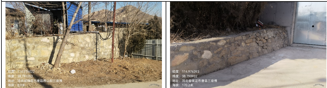
浆砌石挡墙现场照片（建构筑物区）
