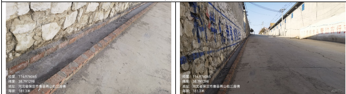
砖砌排水沟现场照片
