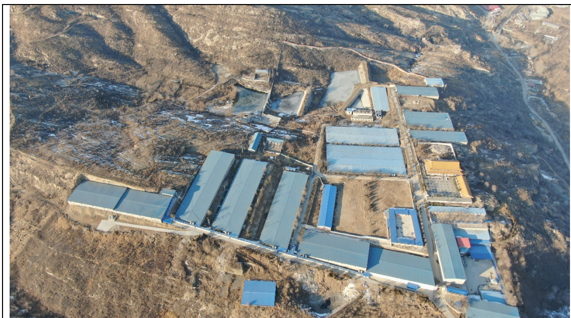
无人机航拍影像
