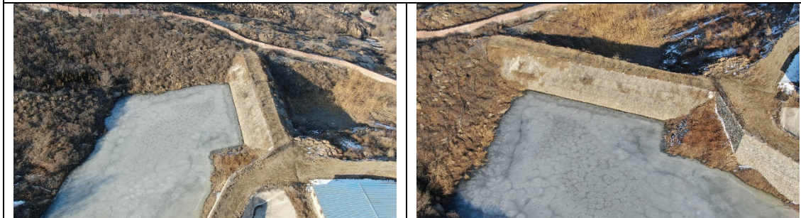
浆砌石挡墙现场照片（土石坝）
