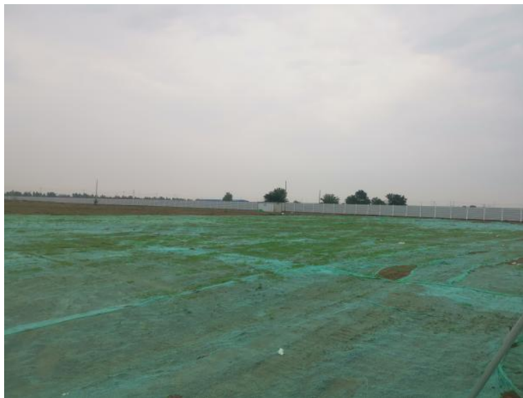
图 2-1 项目区整体苫盖防尘网
